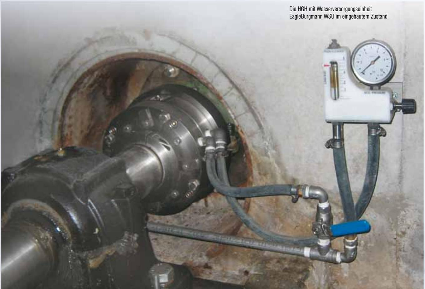
Die HGH mit Wasserversorgungseinheit EagleBurgmann WSU im eingebautem Zustand
