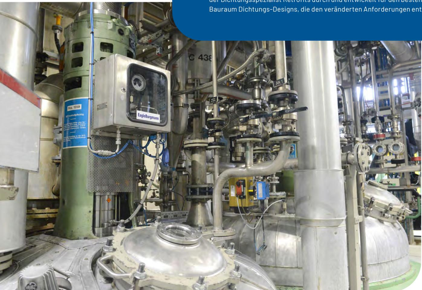
Die oberen Teile von zwei Behältern. Links ist durch die untere Öffnung des grünen Wellengehäuses die Dichtung SeccoMix zu sehen. Oben befindet sich die Instrumentierung des Versorgungssystems für die Dichtung.
