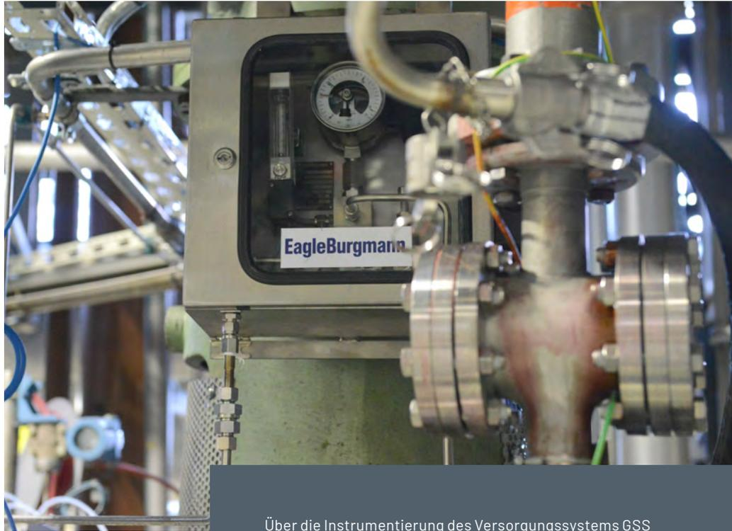
Über die Instrumentierung des Versorgungssystems GSS sind der Gasdurchfluss und die Leckagewerte abzulesen.
