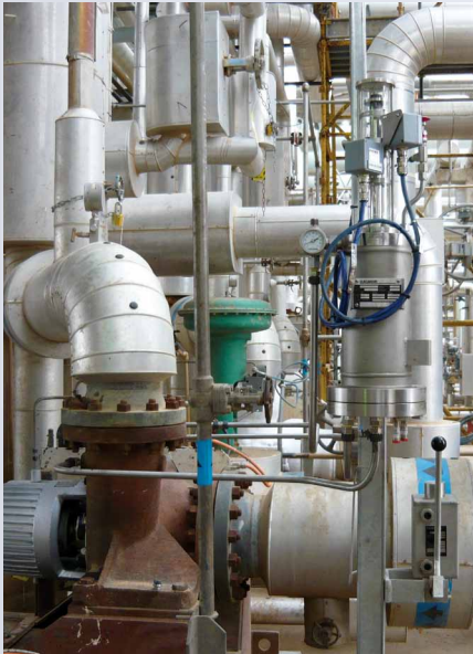
Byron-Jackson-Pumpe ausgerüstet mit einer Gleitringdichtung vom Typ HX75KF-D, versorgt über ein DRU-System.
