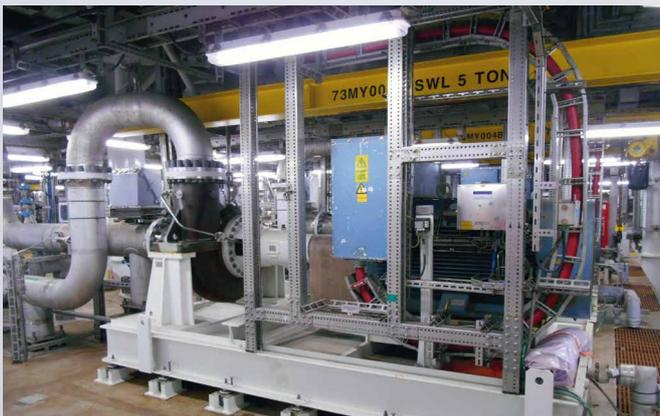
Finder Kühlmedienpumpe (Cooling Medium Circulation Pump) abgedichtet mit Einzeldichtung H75VN/90-E88-A1-OR, versorgt nach API Plan 11.
