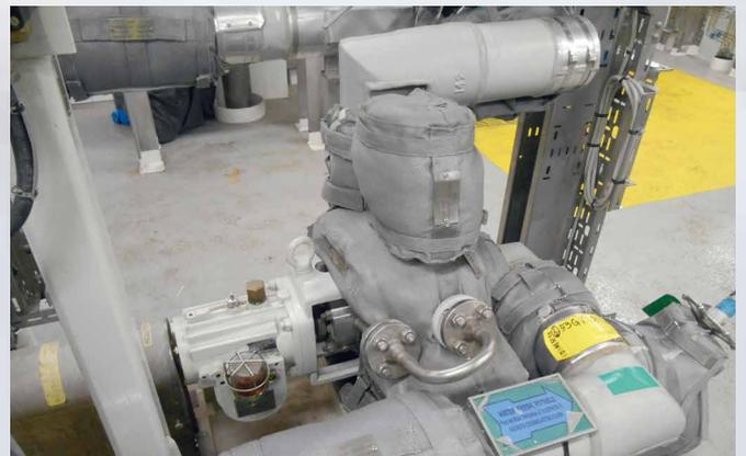
Finder Heißwasser-Zirkulationspumpe (Hot Water Circulation Pump). Sie ist mit einer Einzeldichtung Typ H75VN/50-E87-A4-OR abgedichtet. Versorgung nach API Plan 11.
