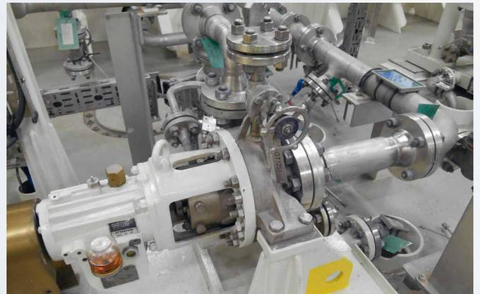
Finder Trinkwasserpumpe mit Einzeldichtung H75VN/50-E93-A1, versorgt nach API Plan 11.
