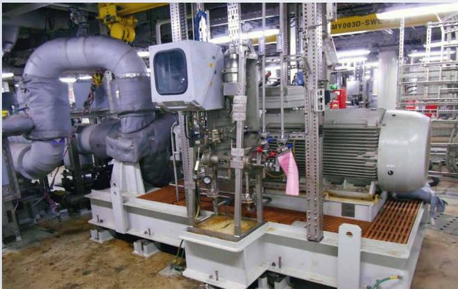
Finder Zirkulationspumpe für Wärmeträgermedium (Heating Medium Circulation Pump) abgedichtet mit H75FD/90-E3-A1 Doppeldichtungen, Versorgung nach API Plan 53B.
