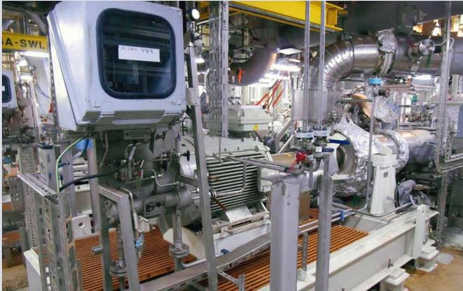
Finder Rohölpumpe (Crude Oil Transfer Pump) abgedichtet mit H75FD/90-E3-A1 Doppeldichtungen, Versorgung nach API Plan 53B.
