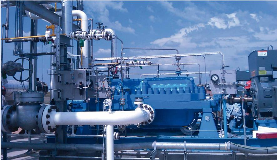
Sulzer Ethanpumpe in einer NGL-Fraktionierungsanlage in Houston/Texas. Pumpe und Dichtung laufen seit der Umrüstung auf die innovative Dichtungslösung EagleBurgmann DFDGS6 im Jahr 2011 störungsfrei.
