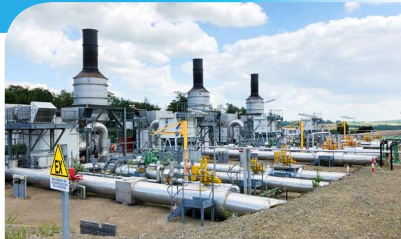
Emissionen sind beim Betrieb von Erdgas-Kompressoren nicht vollständig zu vermeiden: Die auf Verdichterstationen eingesetzten Turbokompressoren haben bauartbedingt Leckagen. Denn die bei hohen Drücken eingesetzten gasgeschmierten Gleitringdichtungen schließen neben anderen Komponenten nicht vollständig ab.
