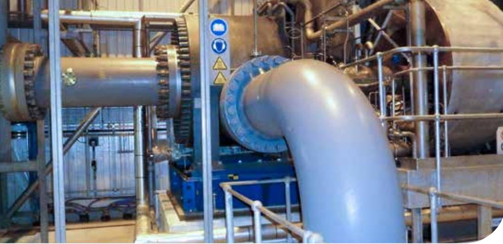
In den Kompressorstationen wird das Gas nach dem Transport durch die Pipelines wieder unter ausreichenden Druck gesetzt. Ein Dichtungsfehler führt typischerweise zu einem unerwarteten Herunterfahren der Maschine, wodurch der Kompressor nicht verfügbar ist.
