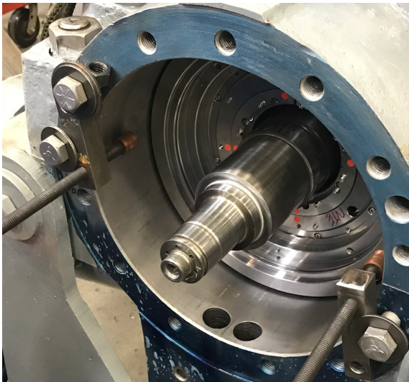
Bild der eingebauten Dichtung
