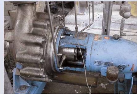
Diese Art der Pumpen mit EagleBurgmann Cartex-Sonderdichtungen wird in verschiedenen Prozessschritten eingesetzt.
